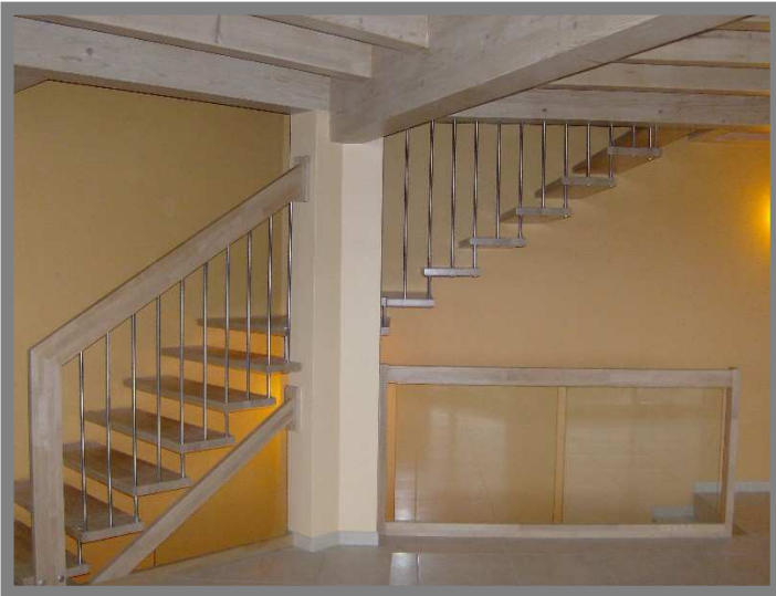
Escalier avec marches suspendues, baraudage inox.
