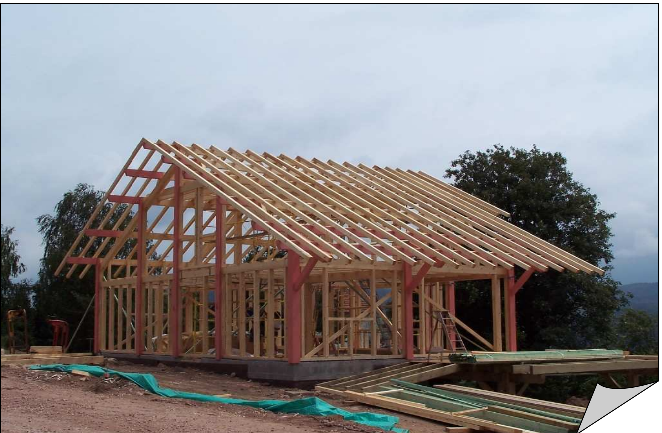
Ossature du projet entièrement montée !!!
