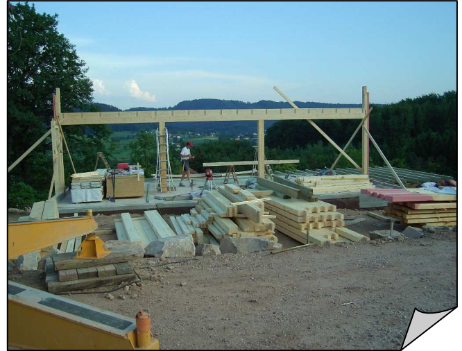
Pose de la 1 ère pièce de bois (pour l'instant tout se passe bien...)
