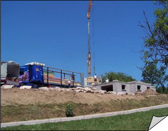
Transport et aménagement du chantier
